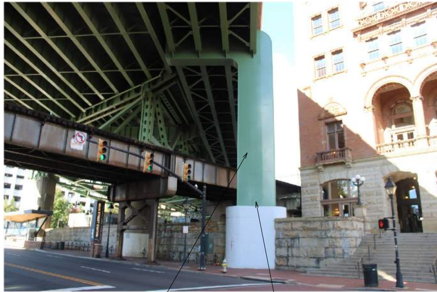
PIER 10E — ACCESS DOOR
